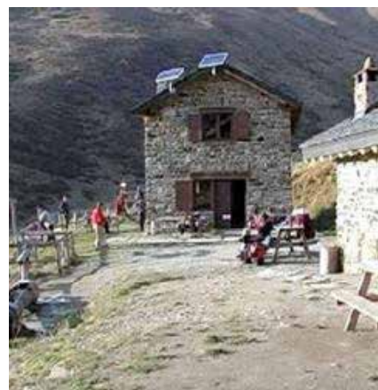
Vezza d'Oglio: Il rifugio "Saverio Occhi" oggetto di interventi migliorativi.
