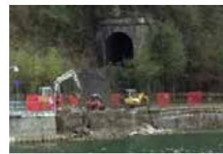
Pisogne. Il cantiere.
