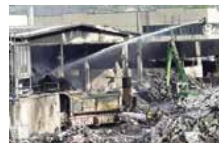
Rogno: L'interno di un capannone dopo l'incendio.
