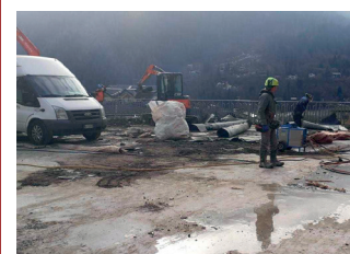
Veza d'Oglio: Iniziati i lavori nel Piazz.le Gregorini.
