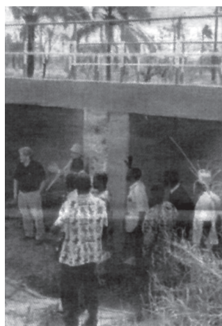
Un ponte realizzato grazie al gemellaggio.
