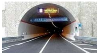
Capodiponte: Inizio della galleria
