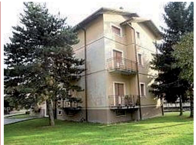
L'edificio ex Eca da demolire
