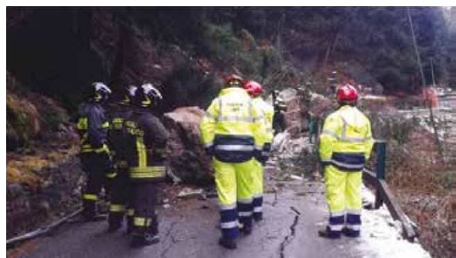
Corteno. La zona della frana.
