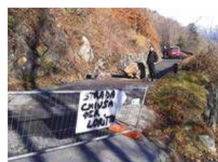
Malonno: La strada per Loritto interrotta dalla frana.
