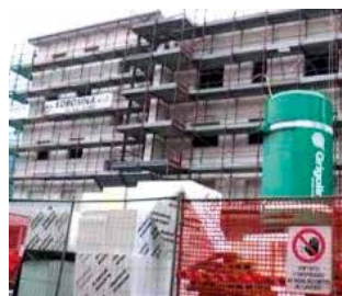
Malegno: L'edificio della Pia Fondazione durante i lavori di ampliamento.
