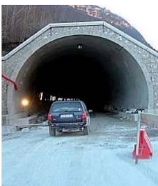
L'imbocco di una delle gallerie
