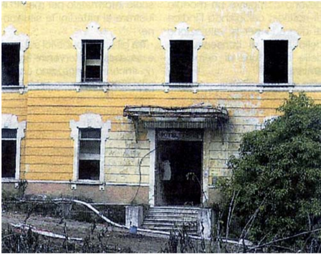
Boario T.: L'Hotel Terme in fase di ristrutturazione
