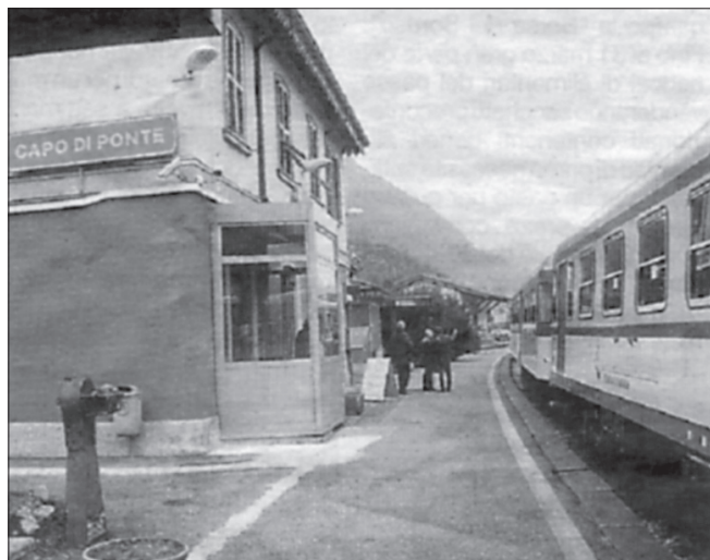
La stazione di Capodiponte diventerà Centro intermodale.
