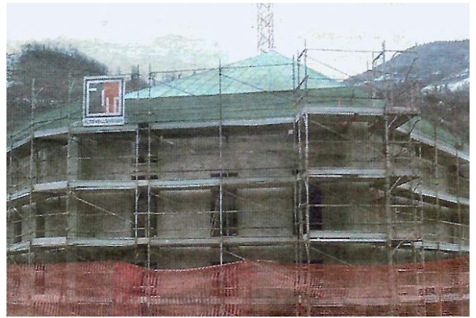
Piancamuno: La chiesa in costruzione.
