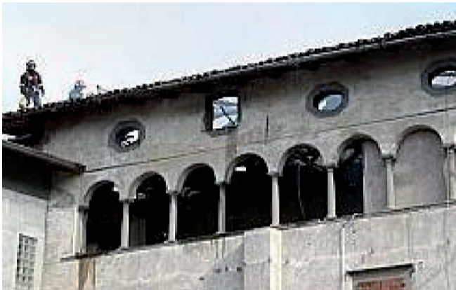
Piancamuno: Vigili sul tetto dell'antico edificio dopo aver spento l'incendio.
