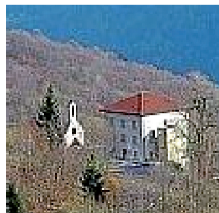
Cevo: La Casa del Parco
