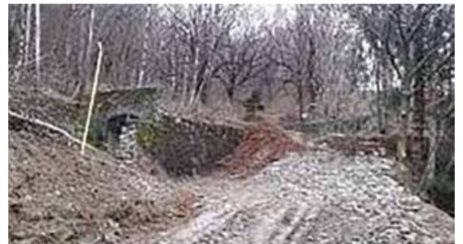
Cantiere aperto per l'interramento delle linee aeree.
