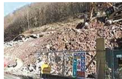
Darfo: Lavori in corso per dare sicurezza al fondovalle.
