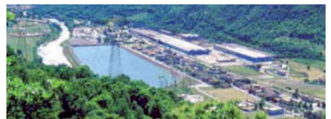
Il bacino artificiale della centrale idroelettrica di S. Fiorano
