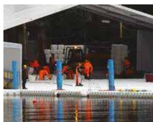
Nei capannoni di Montecolino fervono i lavori.
