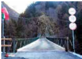
Ceto: Il ponte provvisorio sul torrente Palobbia.
