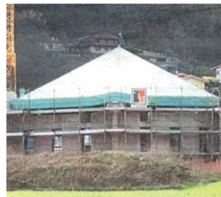
La nuova parrocchiale in costruzione.
