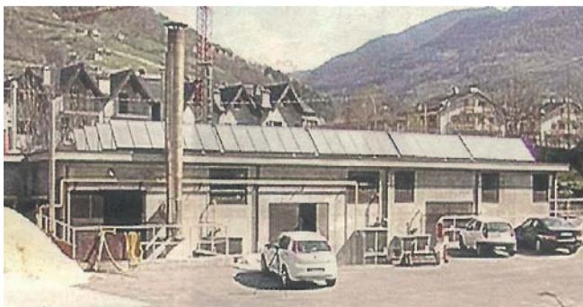
Edolo: La centrale a biomasse.
