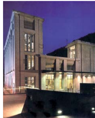
Cedegolo: La sede del Museo dell'energia idroelettrica.
