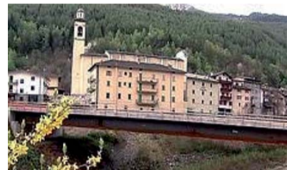
Corteno Golgi: Il nuovo ponte sull'Ogliolo
