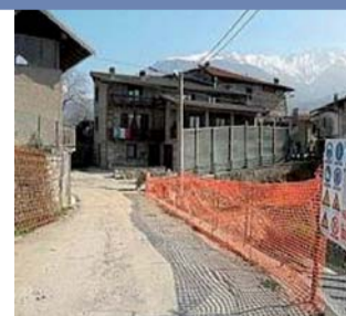
Ono S. Pietro: Il cantiere per la messa in sicurezza del Cricolo.
