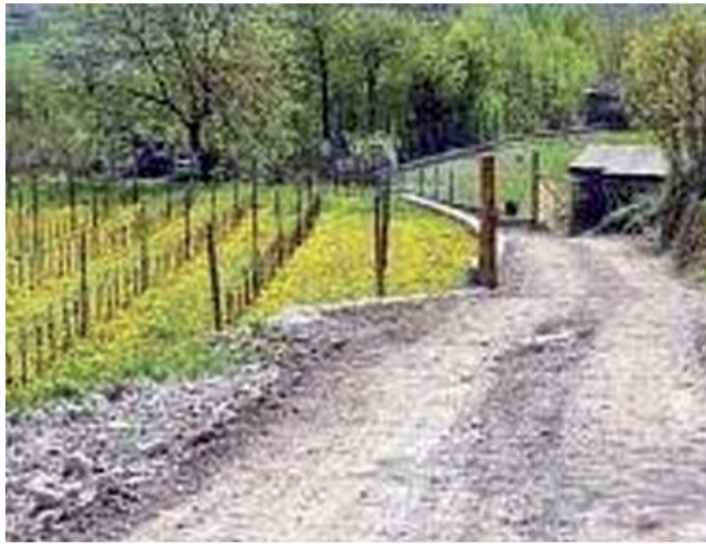
Ono S. Pietro: iniziati i lavori della strada del vino
