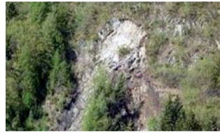
Ceto: La frana provocata dalla fuoruscita da acqua dal canale.
