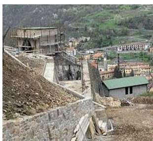
Sellero: Il cantiere di recupero della vasca
