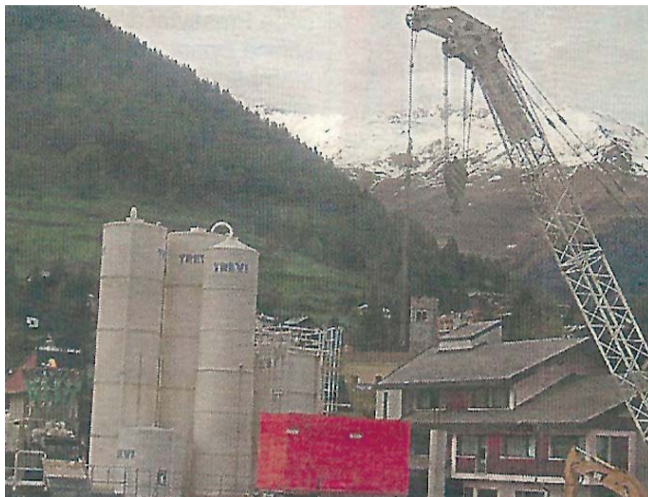
Ponte di Legno: Ripresi i lavori per il parcheggio.
