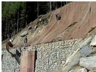
Rocciatori in azione per mettere in sicurezza il pendio
