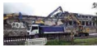
Un mese di lavori per ripristinare il transito ferroviario.
