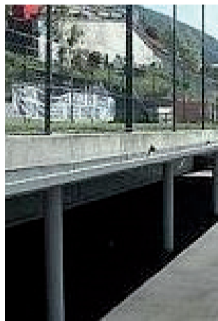
Vione: La nuova struttura sportiva di Canè
