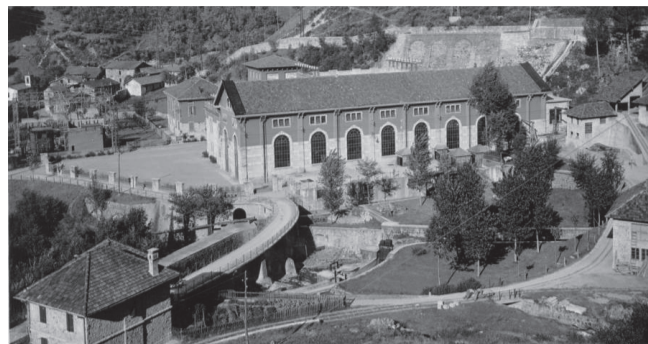
Sonico: Veduta dall'alto della Centrale idroelettrica
