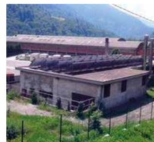
Edolo: la centrale del teleriscaldamento.
