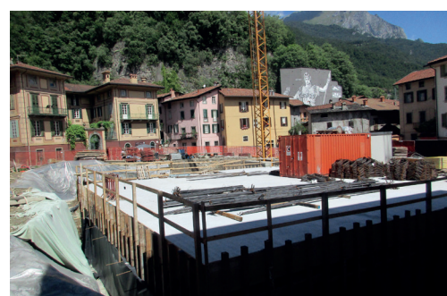
Breno: Lavori in corso per la nuova piazza.
