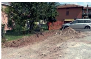
Darfo: Lavori per il nuovi parcheggi.
