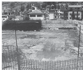
Pontedilegno: Il cantiere di piazzale Europa oggetto di attente verifiche.
