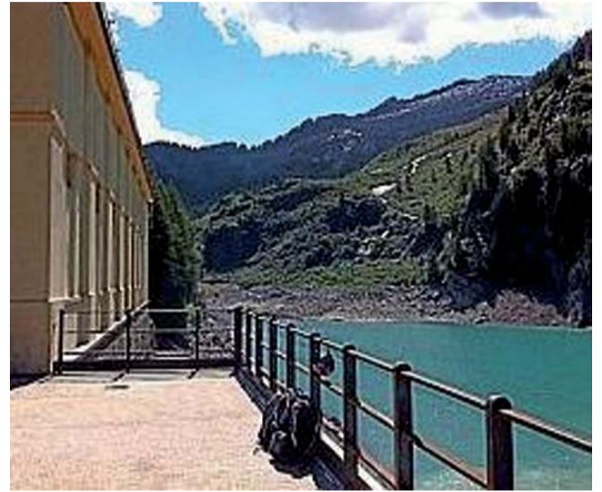
La centrale idroelettrica di Campello
