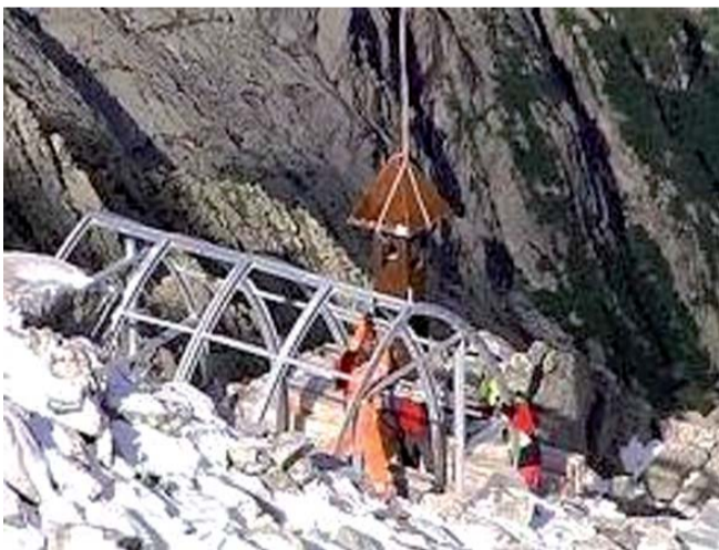
Cima Lagosuro: Operai al lavoro per ancorare la struttura portata in quota dall'elicottero
