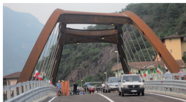
Darfo B.T.: Il nuovo ponte aperto al traffico.
