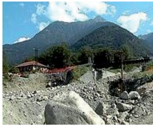
Una veduta dell'area dove sono iniziati i lavori
