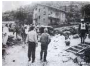
Niardo: I primi interventi dopo il disastro.
