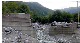
Il ponte che collega Ono San Pietro a Cerveno spazzato via dalla frana.
