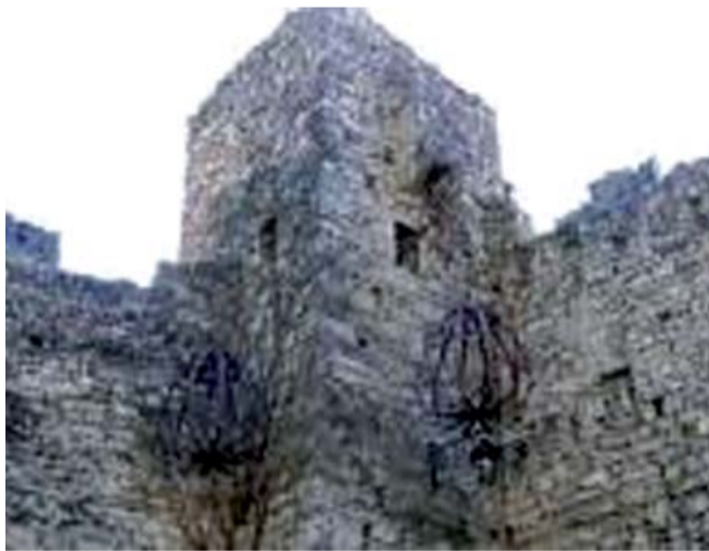
Breno: Un particolare del Castello prima dei lavori di restauro.
