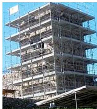
La torre avvolta dai ponteggi.
