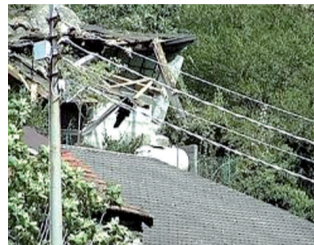
L'abitazione colpita dalla frana
