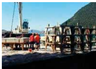
Sulzano: Proseguono i lavori per il recupero del materiale usato per la passerella.
