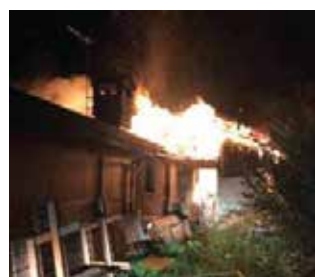
Temù: Le fiamme che hanno distrutto tre cascinali.
