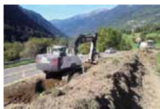
Vione: Lavori sul bivio con la Statale.
