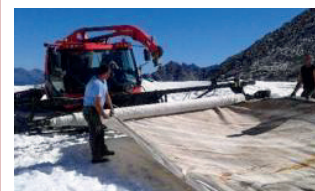
Ghiacciaio Presena: La rimozione delle coperture geotessili.
