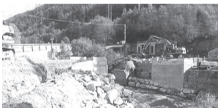
Il cantiere per la ricostruzione del ponte.
