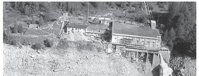
La centrale dell'Enel oggetto di manutenzione.
