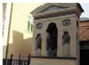
Montecchio: La santella restaurata.
