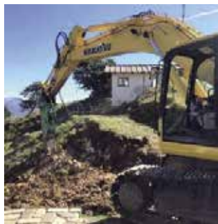
Borno: Lavori in corso.
