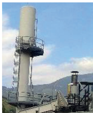
Sellero: La centrale a biomassa.
