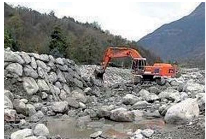
I lavori di messa in sicurezza degli argini
