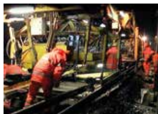
Operai in azione per sostituire i binari.
