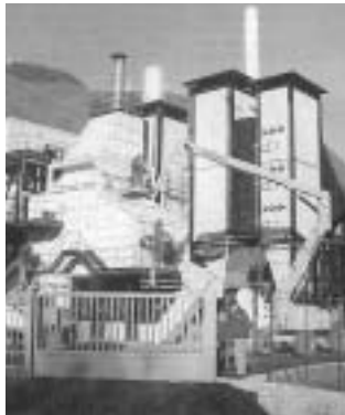
Sellero: La centrale a biomasse vegetali recentemente inaugurata.
