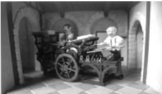
Operatori al lavoro con la prima rotativa.
