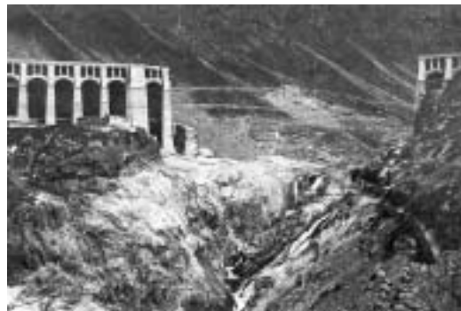
Lo squarcio della diga del Gleno che il 1° dicembre del 1923 provocò più di 350 morti.
