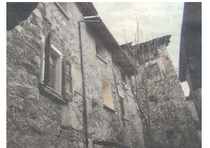
Cerveno: Edificio del centro storico da recuperare.
