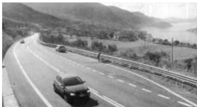
Un viadotto della nuova SS 510, sullo sfondo il lago d'Iseo.
