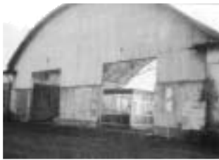
Piancamuno: Il capannone della Carbofer dove si vorrebbe realizzare l'impianto per il trattamento dei rifiuti.
