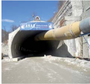
L'ingresso della galleria "Capodiponte"
