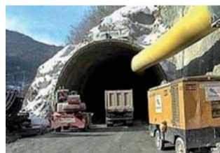
L'entrata della galleria
