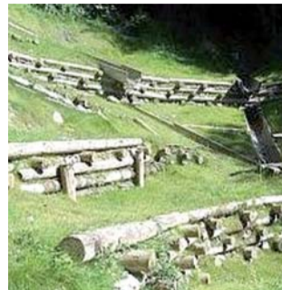
Interventi di contenimento delle frane
