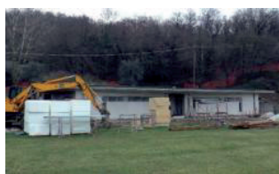
Montisola: I lavori per i nuovi spogliatoi.
