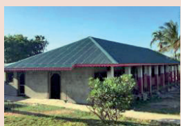
Il nuovo orfanotrofio durante i lavori.
