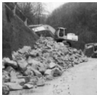
Macchine al lavoro dopo una frana.
