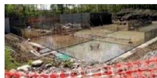
Esine: Uno dei cantieri per il raddoppio del depuratore.
