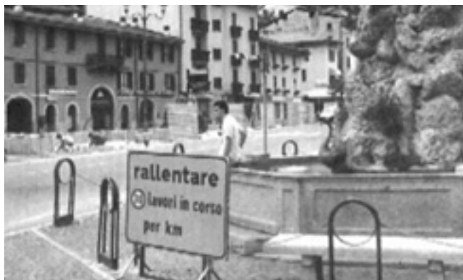
Il centro di Edolo, dove sono iniziati i lavori di abbellimento dell'intera area.
