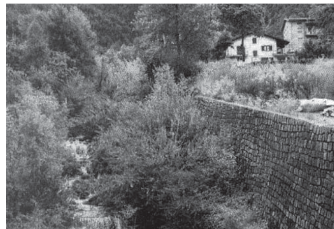
Niardo: Opere di contenimento del torrente Re realizzate dopo l'alluvione del 1987.
