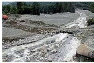
L'attraversamento provvisorio realizzato sul torrente Rabbia
