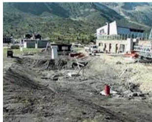
L'area del cantiere; già pronti i primi pilanti
