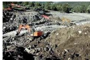
... e la ripresa dei lavori dopo la nuova frana.
