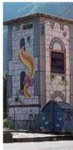
La cabina elettrica che racconta una fiaba
